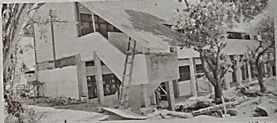
» Pembangunan ruang kelas baru di SMP Negeri 12 Bitung mengalami keterlambatan. Akibatnya, kontraktor pelaksana proyek dikenai sanksi denda. (ist)
